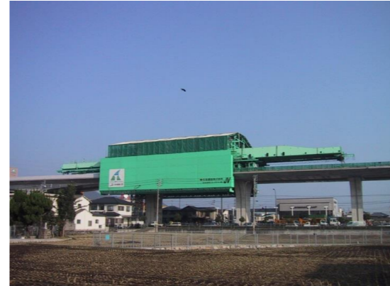
種類 : 大型移動支保工(ゲリェスワーゲン)による一括架設/側面 撮影日 : 2001年10月25日
