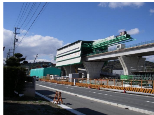
種類 : 大型移動支保工(ゲリェスワーゲン)による一括架設/全景 撮影日 : 2007年3月7日
