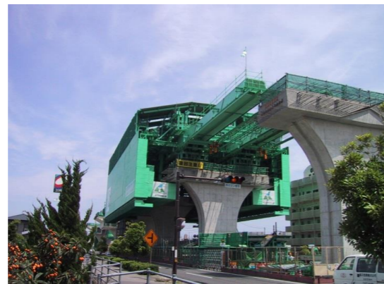
種類 : 大型移動支保工(ゲリェスワーゲン)による一括架設/正面 撮影日 : 2001年6月8日
