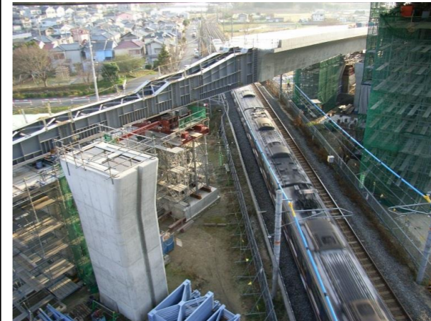
No. 3 O. 倉治跨線橋
