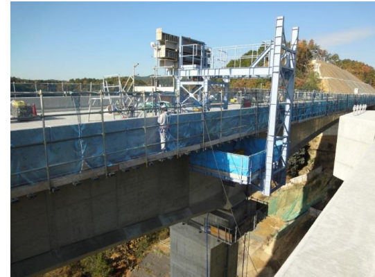
No. 5 O. 楊梅山高架橋
