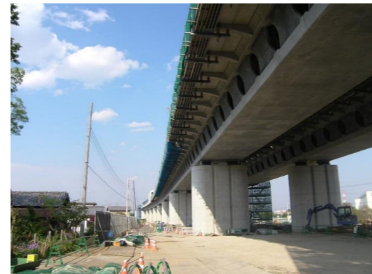
No. 8 D. 桶川第二高架橋(2)
