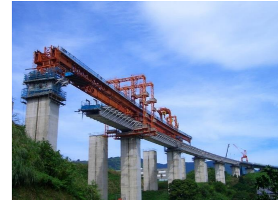
No. 9 E. 山切1号高架橋
