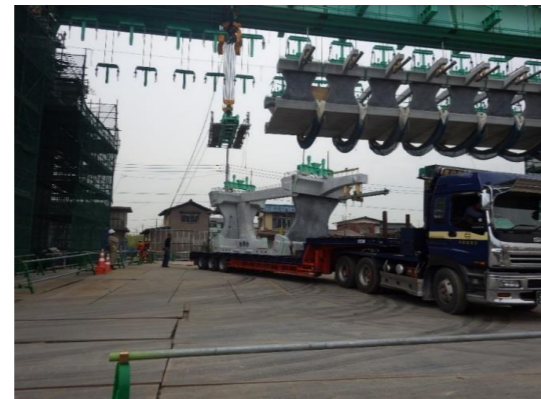
No. 7 D. 桶川第二高架橋(1)
